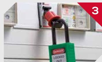
3 Une fois appliquée sur l'interrupteur, immobilisez le dispositif avec un cadenas inséré dans le trou du bouton.
