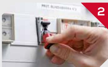
2 Appuyez sur le bouton pour ajuster les boulons aux interrupteurs.
