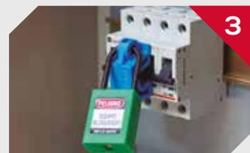
Placer le blocage en position sur l'interrupteur.
