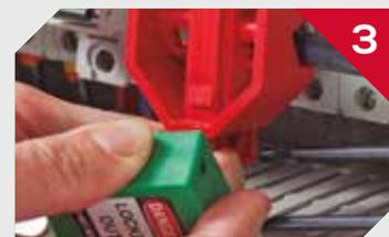
3 Placer le cadenas pour bloquer l'appareil.
