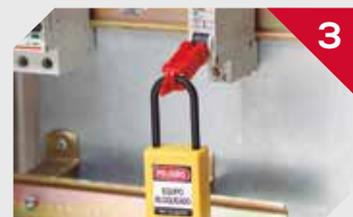
S'assurer que l'interrupteur est éteint avant de placer le verrou, puis le placer en position.
