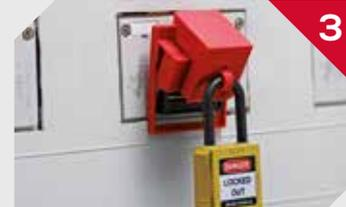
3 Placez la couverture sur la roue et bloquez le dispositif avec un cadenas.
