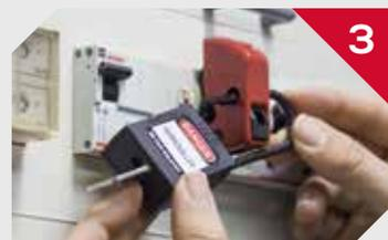
Placer le dispositif de verrouillage dans la position représentée sur l'image.
