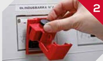
2 Placez la plaque dentelée du blocage sur l'interrupteur et tournez la roue pour régler le dispositif.
