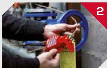
Introduisez ensuite le câble dans l'orifice sur le côté du porte-cadenas et tendez-le. (Il est conseillé de signaler la zone en faisant passer une étiquette à travers le câble avant de l'introduire dans le porte-cadenas).
