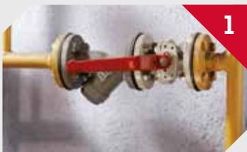
1 Placer le verrou sur le robinet d'arrêt de la vanne.
