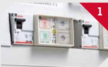
1 Vérifiez si l'interrupteur est activé ou non avant d'ajouter le blocage.
